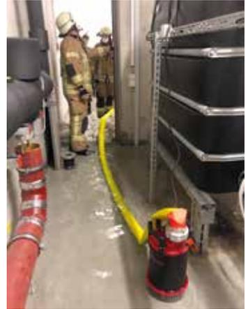
So errichteten wir mit etwa 20 Sandsäcken eine Barriere, um die Bereiche zu schützen. Zugleich wurde mit mehreren Tauchpumpen das Wasser zurückgedrängt und nach Stoppen des Austritts beseitigt.
