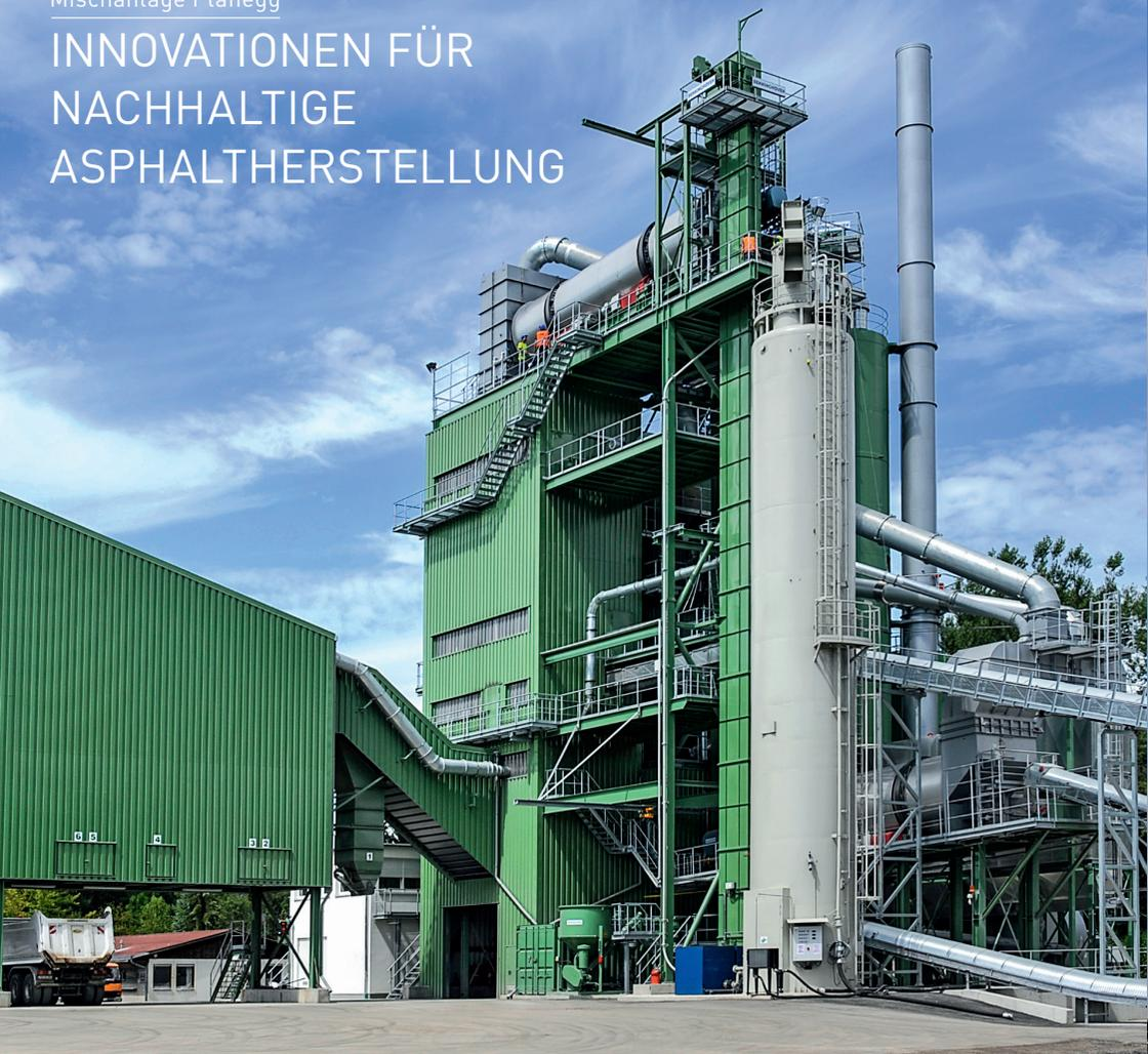
Die bam hat 1984 in Planegg bei München weltweit das erste Asphaltmischwerk mit Paralleltrommel in Betrieb genommen und diese Technik der schonenden Erwärmung des Asphalt-Recyclingmaterials kontinuierlich weiterentwickelt. So gewährleistet die bam, dass angelieferter Ausbauasphalt wieder in den Kreislauf zurückgeführt und in neu produziertem Asphalt eingesetzt wird. Dies ist äußerst umweltfreundlich und schont die Ressourcen an natürlichen Rohstoffen sowie Deponieraum.
